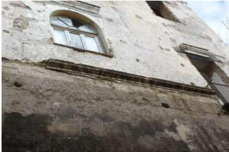
**Figura 1** La facciata ovest del fabbricato, in evidenza il cornicione marcapiano.
