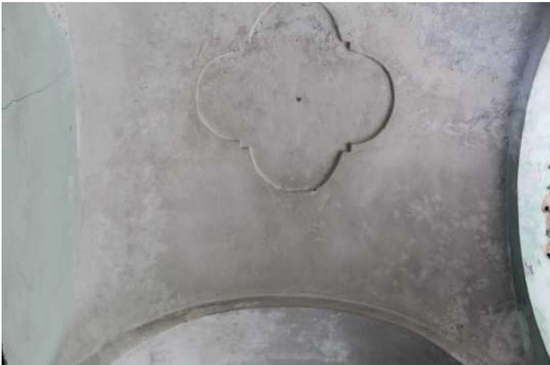
**FOTO 13** Volta a vela con decorazione sottosquadro presente al piano rialzato nello scalone.
