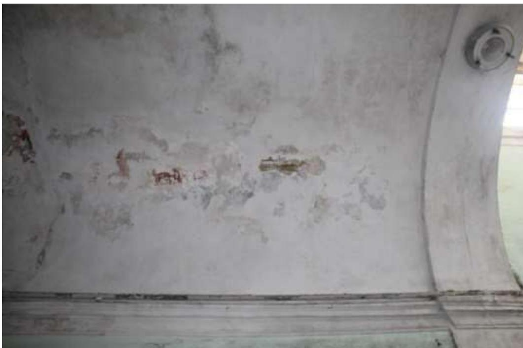
**Foto 2** Volta d'ingresso in seguito alla caduta di tinta murale soprammessa sono emerse tracce di dipinti murali.
