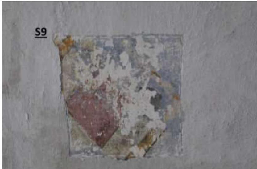
**Foto 7** Saggio **S9** realizzato in corrispondenza della volta d'ingresso.
