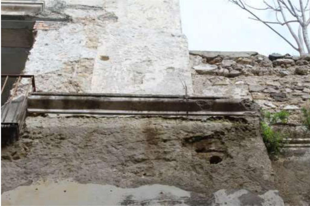
**Figura 12** E' presente anche una diffusa patina biologica che si evidenzia in macchie dal colore bruno intenso fino alla consistenza spugnosa, causata da biodeterogeni
