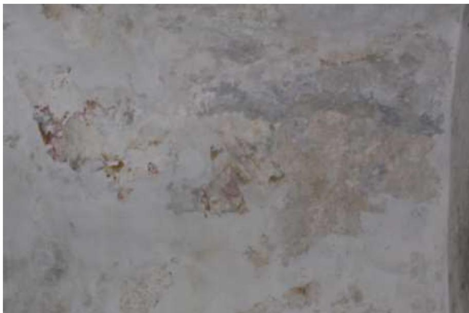
**Foto 5** Nel dettaglio le tracce di dipinti emerse al centro della volta. L'azione dell'umidità ha prodotto l'espulsione di nitrati e solfati che si manifestano superficialmente con efflorescenze saline.
