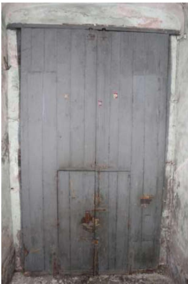
**Foto 2** Il portone all'interno appare completamente rivestito da una pannellatura in abete, con funzione statica
