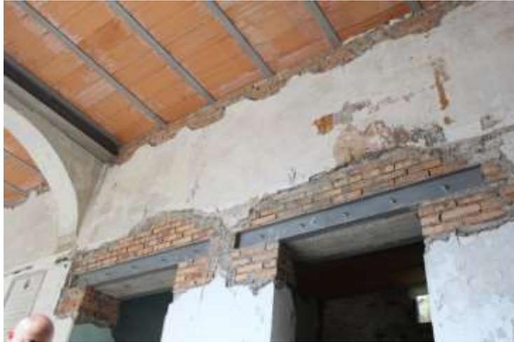
**Foto 9** Nel dettaglio le tracce di dipinti murali al di sotto dello strato di scialbo. Sono presenti lacune dell'intonaco in corrispondenza del solaio e della piattabanda in corrispondenza di un ingresso.
