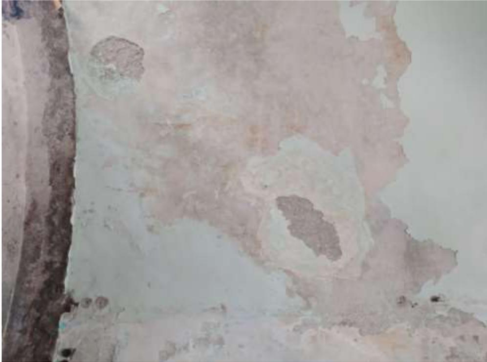
**FOTO 19** Volta a botte con dipinto murale presente nella camera adiacente il portico. Nell'immagine il dettaglio della superficie d'intonaco, con le lacune del supporto, sono presenti tracce esigue di pellicola pittorica.
