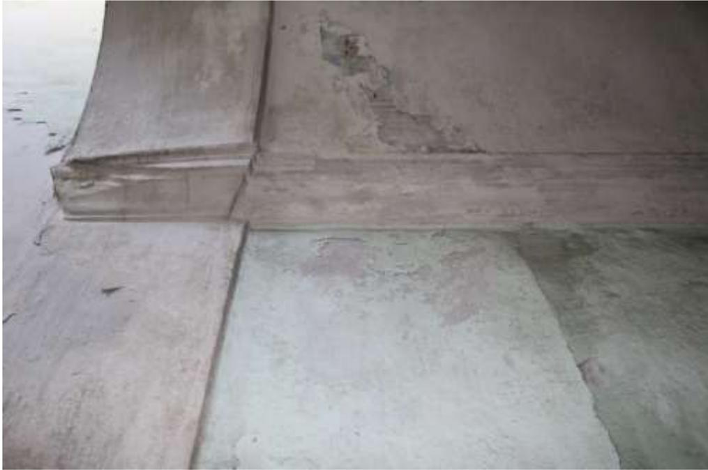
**FOTO 7** Nell'immagine è visibile il cornicione all'ingresso in corrispondenza della volta a botte. E presente una mancanza parzialmente ricostruita con materiali non idonei.
