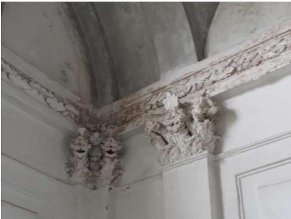
**FOTO 15** Il materiale soprammesso (rasante cementizio), in seguito all'azione dell'umidità ha rigonfiato assumendo una consistenza spugnosa.
