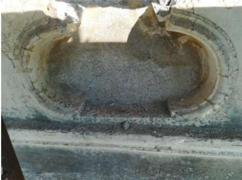
**Figura 10** E' presente anche una diffusa patina biologica che si evidenzia in macchie dal colore bruno intenso fino alla consistenza spugnosa, causata da biodeterogeni.
