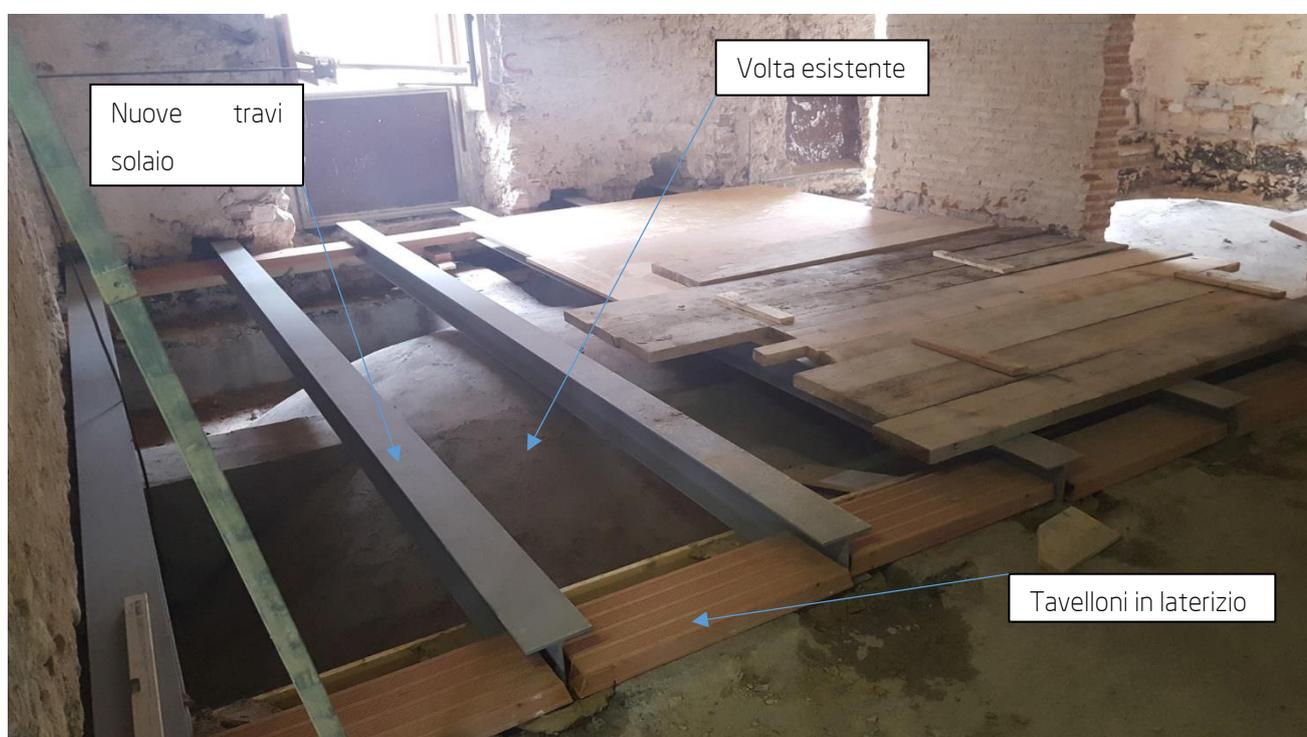
Figura 4: Realizzazione di solaio su volta esistente
