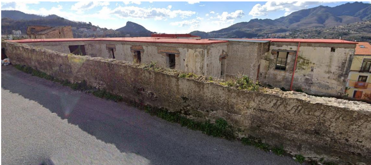
Foto n° 1: Vista da via Oreste di Benedetto
