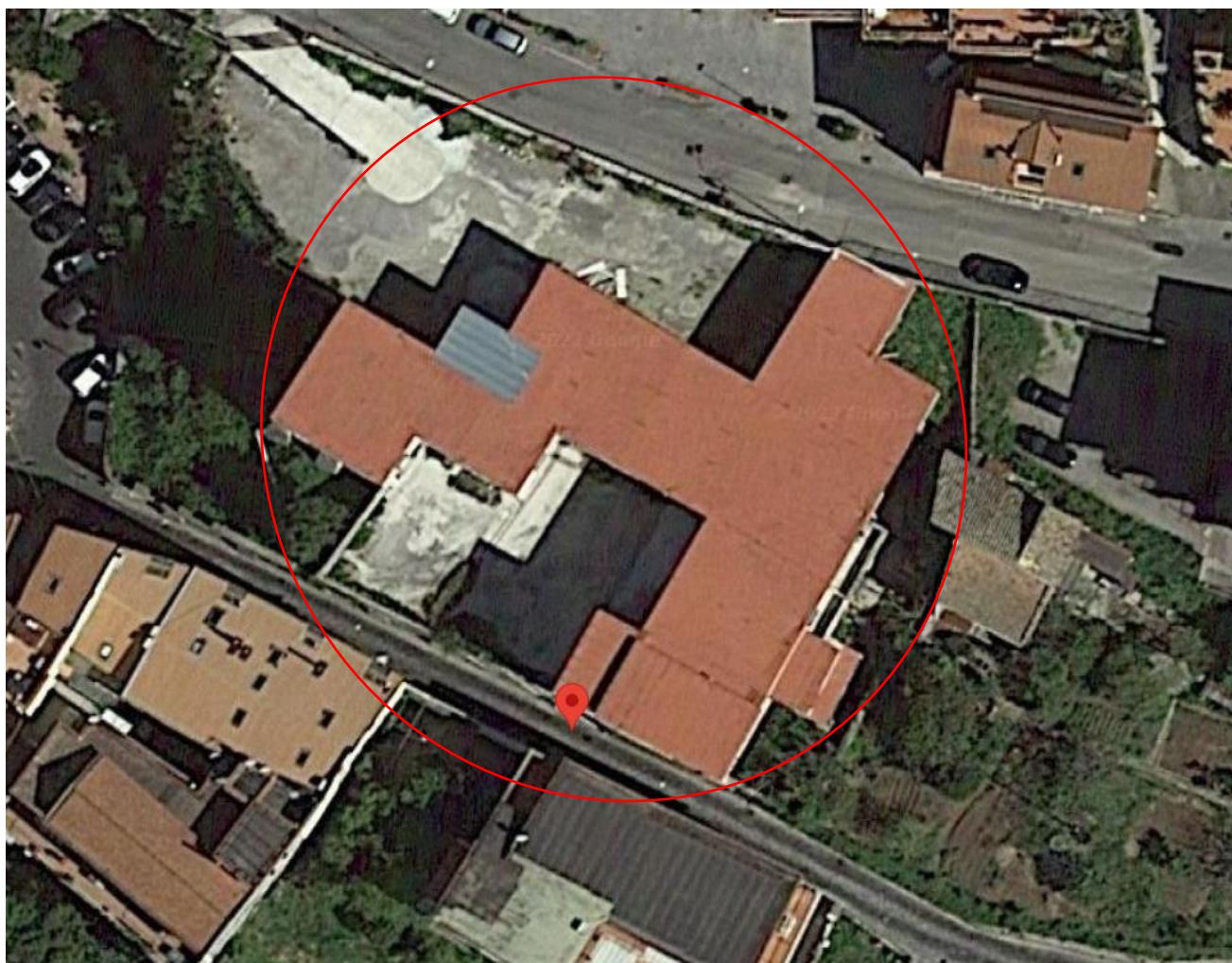
Figura 2: Vista dall'alto dell'edificio in oggetto
