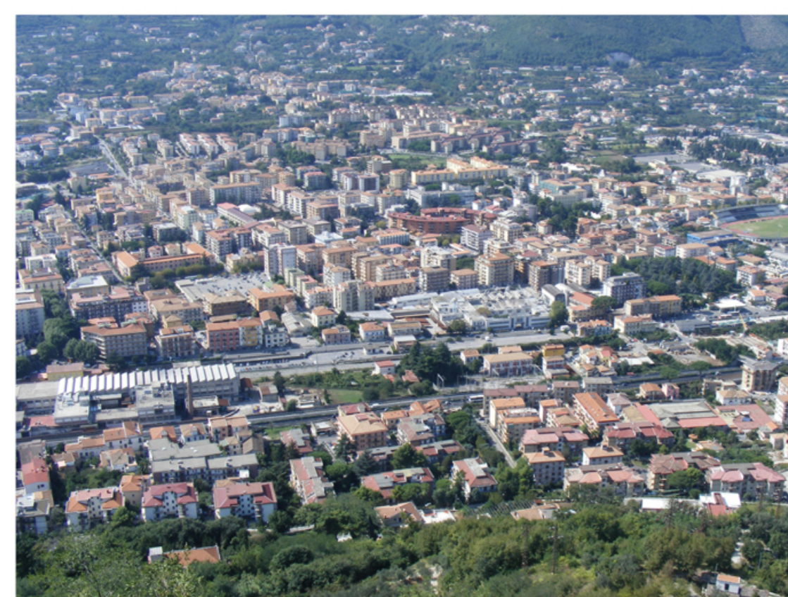
l'espansione consolidata di fondovalle
